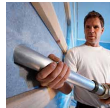
Att spruta lösull i väggar ger bästa slutresultat.
